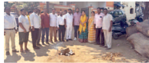
మేడ్చల్ మున్సిపల్ 3వ వార్డులో అందర్నోగ్ డ్రైనేజీ పనులు నిర్వహించిన చైర్మన్ దీపిక నర్సంహరెడ్డి
